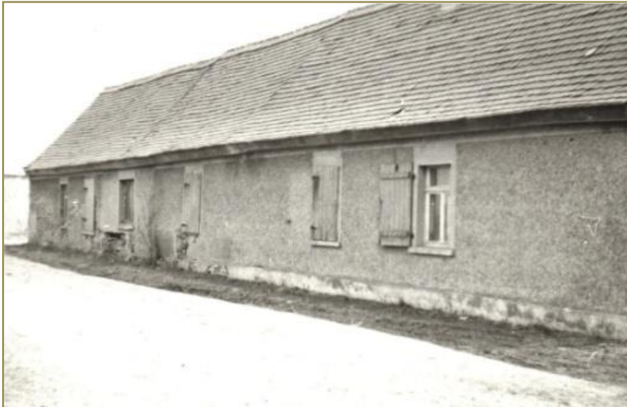
Ein Teil von Ohmes Ziegelei, die inzwischen vollkommen abgerissen ist, an der Landstraße zwischen Löberitz und Zörbig im Jahr 1978
